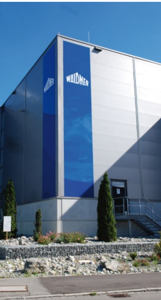
Abb. 1: Die neue Fertigungsanlage am Standort Wangen.
