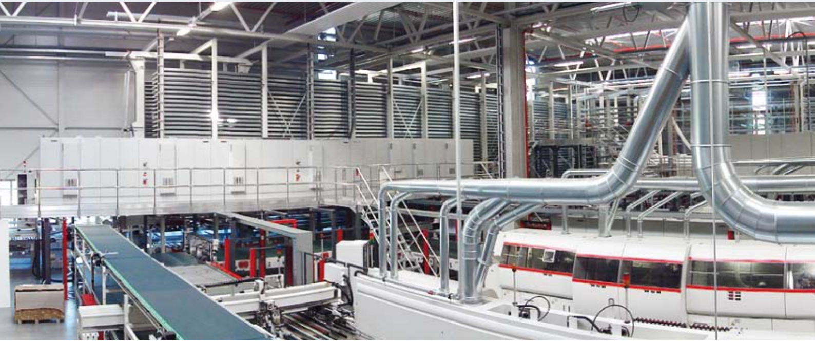
Förderstrecke (links) zum Sortierpuffer (im Hintergrund). Conveyor line (on the left) to the sorting buffer (in the background).
